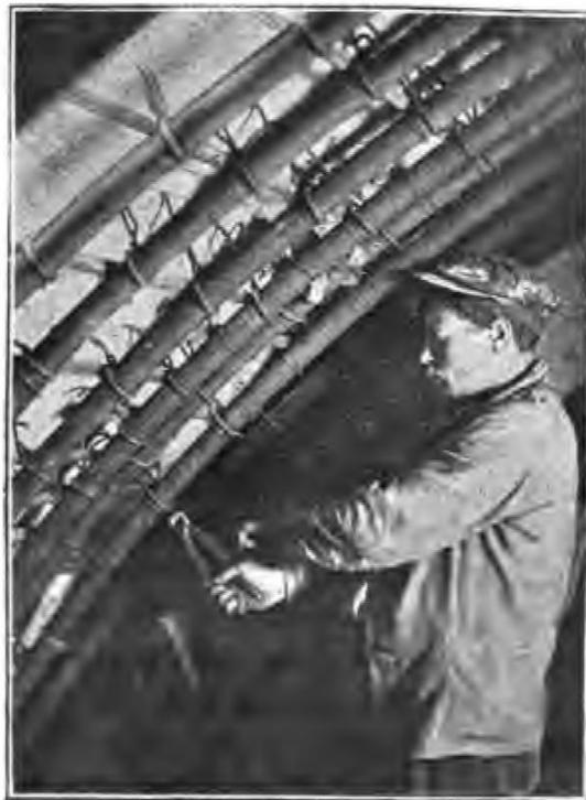
*Tunnel de Meudon : attache de l'armature sur les flancs.*
